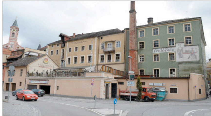
Rundum-Sanierung im Traditionsbau Peschl: Im stillgelegten grünen Brauereigebäude entstehen demnächst eine ebenerdige Garage sowie Gewerbeeinheiten und unterm Dach Wohnungen. Im gelben Gebäude links daneben werden auf zwei Stockwerken ebenfalls Wohnungen geschaffen und Dachsanierungen stattfinden. Auch die Terrasse des namensgebenden Lokals „Peschl-Terrasse“ wird neu aufgebaut. – Foto: Geisler
